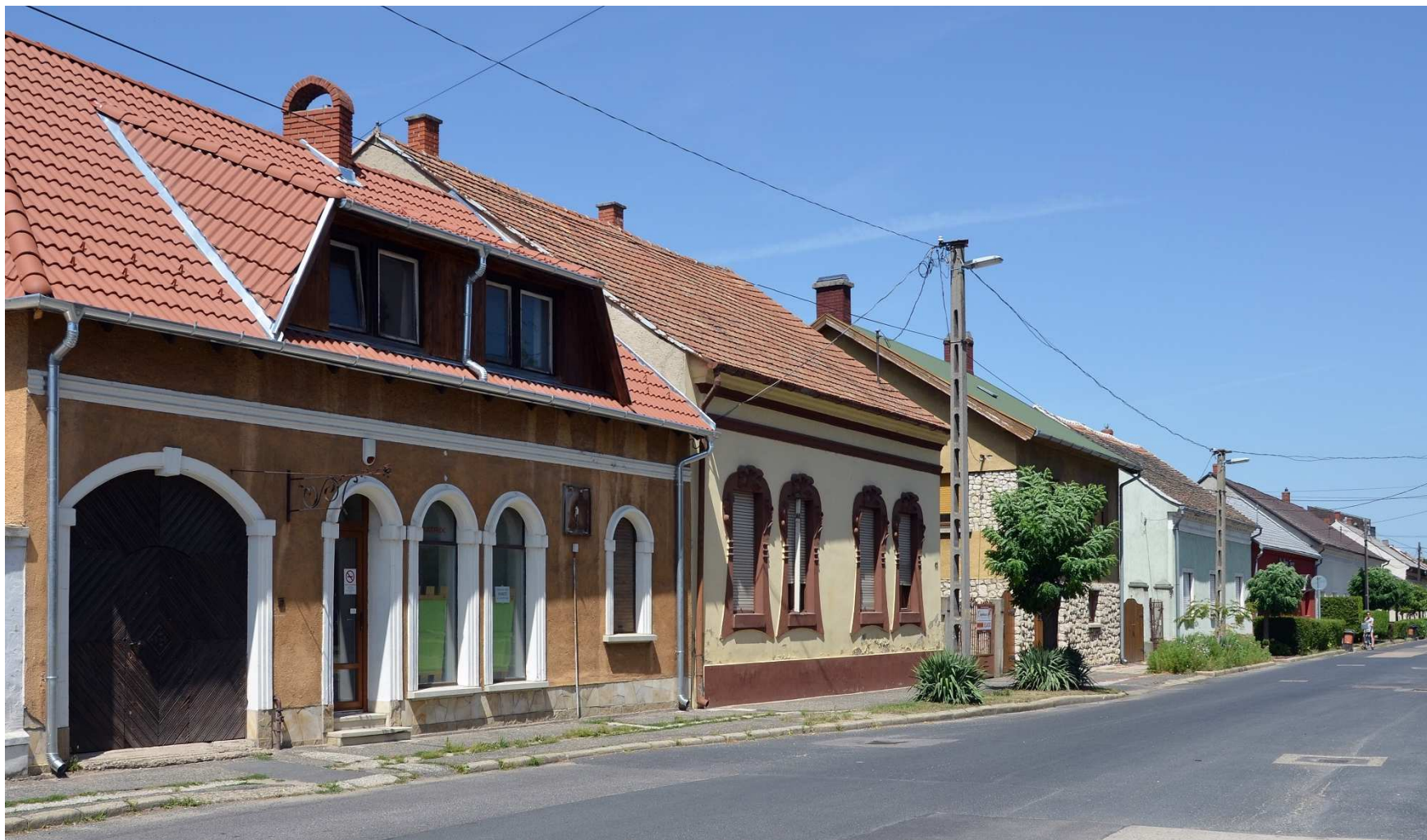
A vasútállomáshoz vezető másik út, a Dózsa György utca
