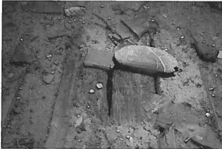
A fedélszék és fa zárófödém a beázások és szuvasodás következtében károsodott
