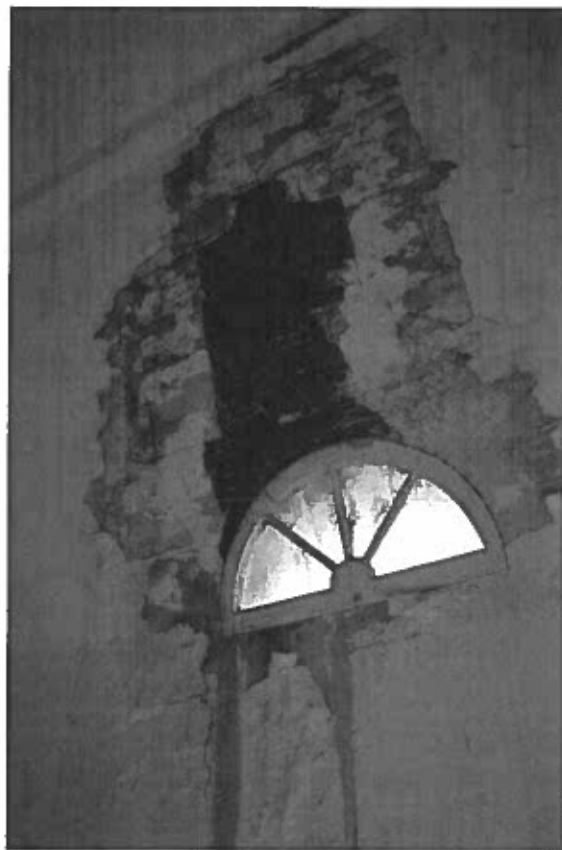
A beázások a belső terek határoló szerkezeteiben jelentős károkat okoztak
