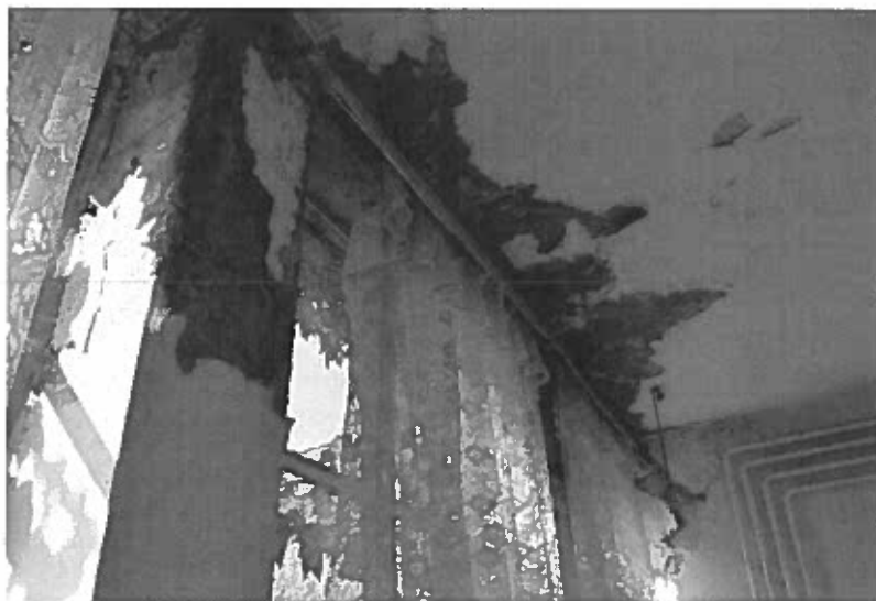
A beázások a belső terek határoló szerkezeteiben jelentős károkat okoztak
