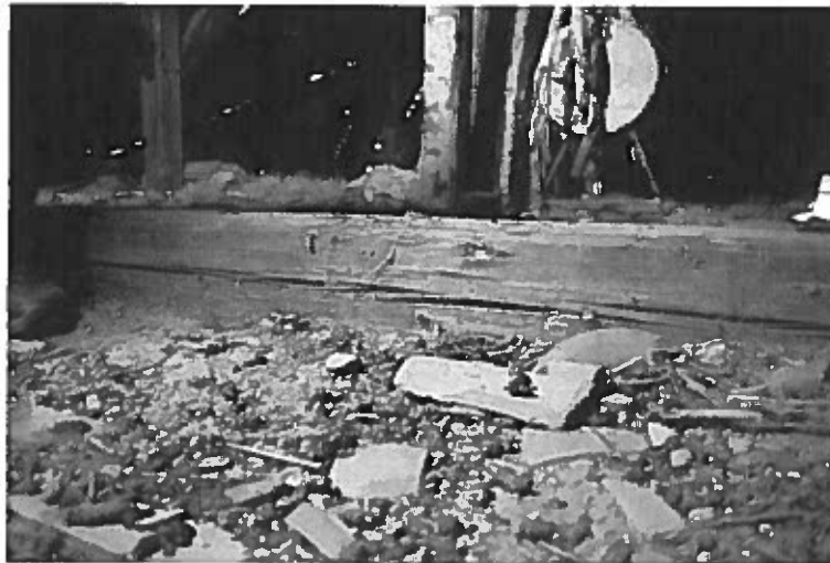
A fedélszék és fa zárófödém a beázások és szuvasodás következtében károsodott
