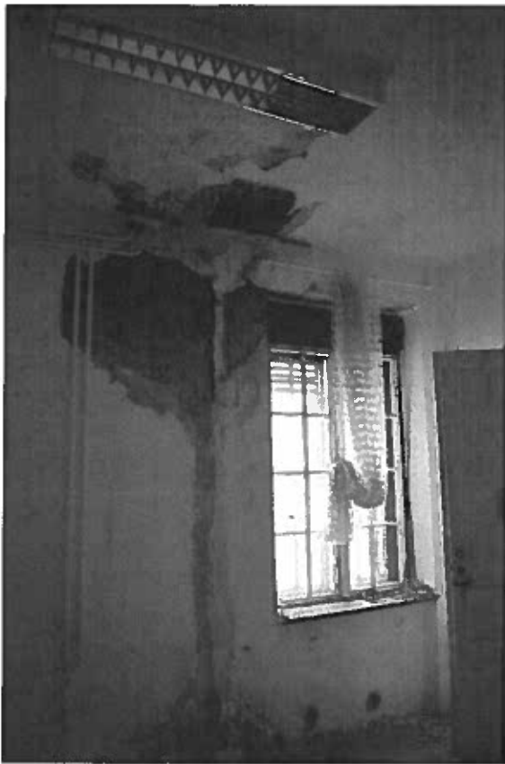
A beázások a belső terek határoló szerkezeteiben jelentős károkat okoztak
