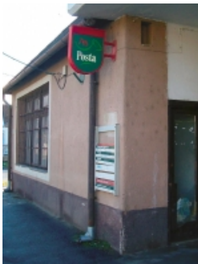
AZ ALSÓSÁGI POSTA ÉPÜLETE
