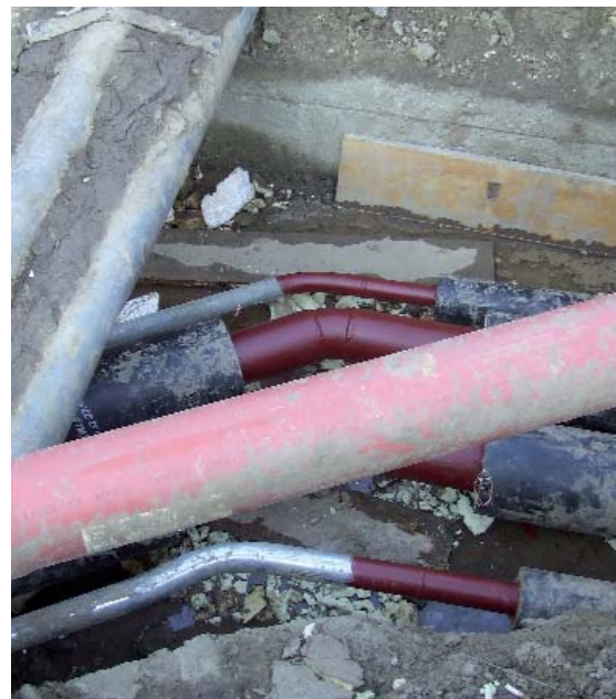
A VÉDŐCSŐ ÉS A BENNE LÉVŐ VEZETÉKEK IS TELJES CSERÉRE SZORULTAK
